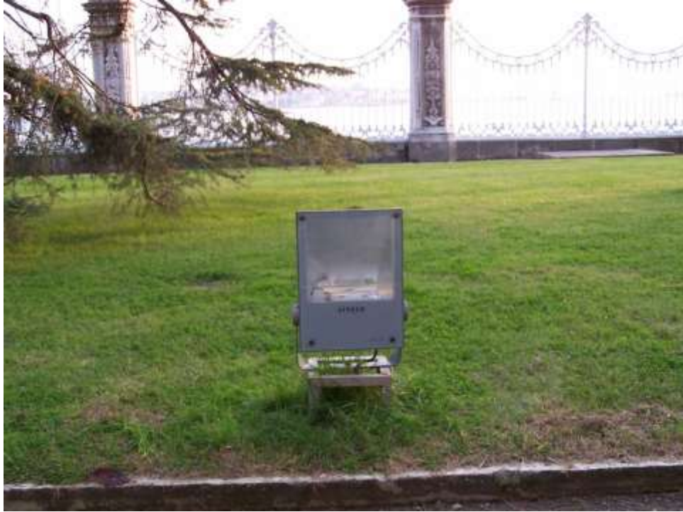
Resim 28 – Ön bahçede bir aydınlatma elemanı detayı
