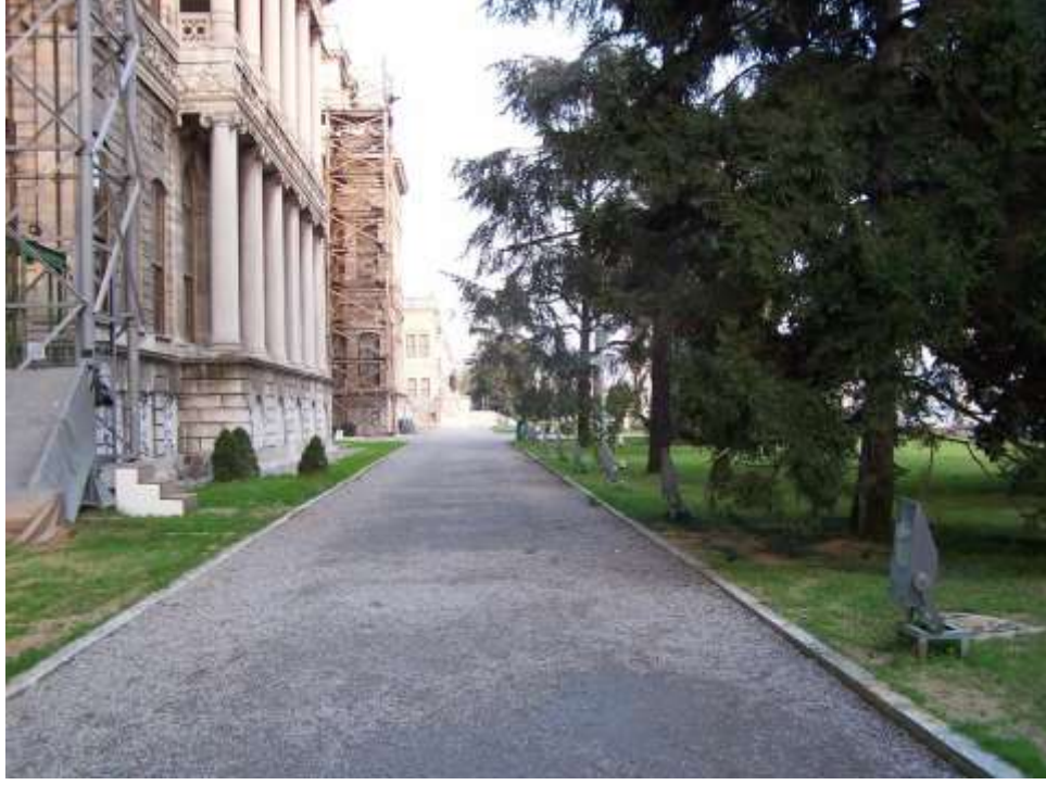
Resim 21 – Ön bahçe bandının yapıya paralel aks boyunca genel görünümü
