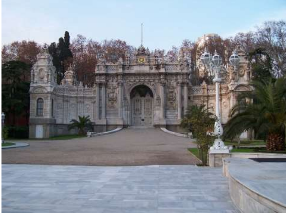
Resim 9 – Saltanat Kapısı'nın Hasbahçe'den görünümü
